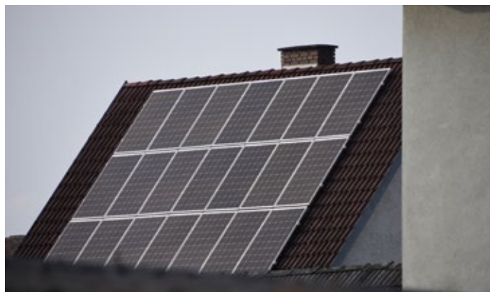
Erneuerbare Energien fördern
